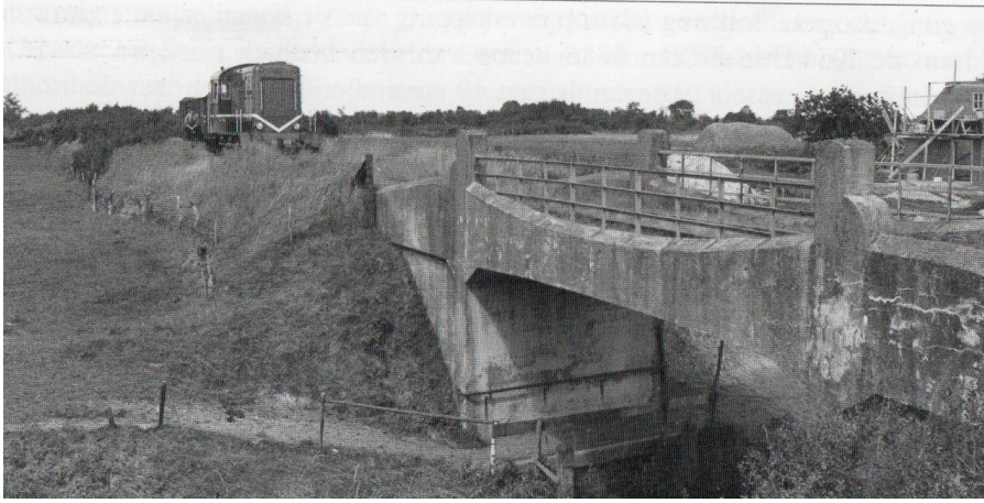
De betonbrug in Hoornsterzwaag
